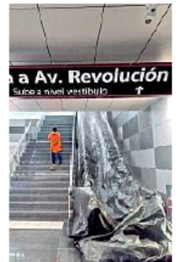
■ Escaleras eléctricas fuera de servicio en la estación Plaza de la Bandera.
