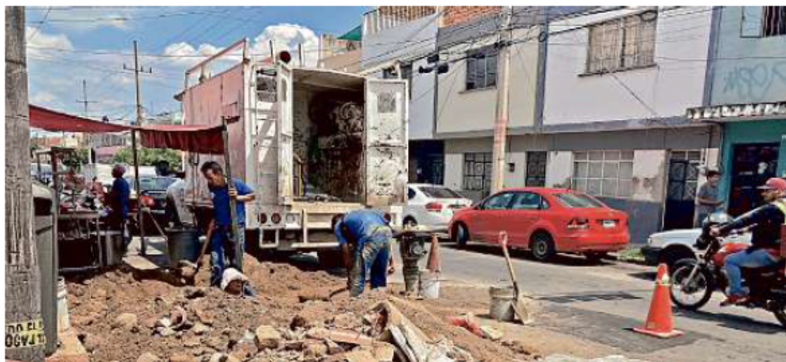
■ Reparación de fuga de agua en Andrés Terán y Jesús García, en la Colonia Santa Teresita.
