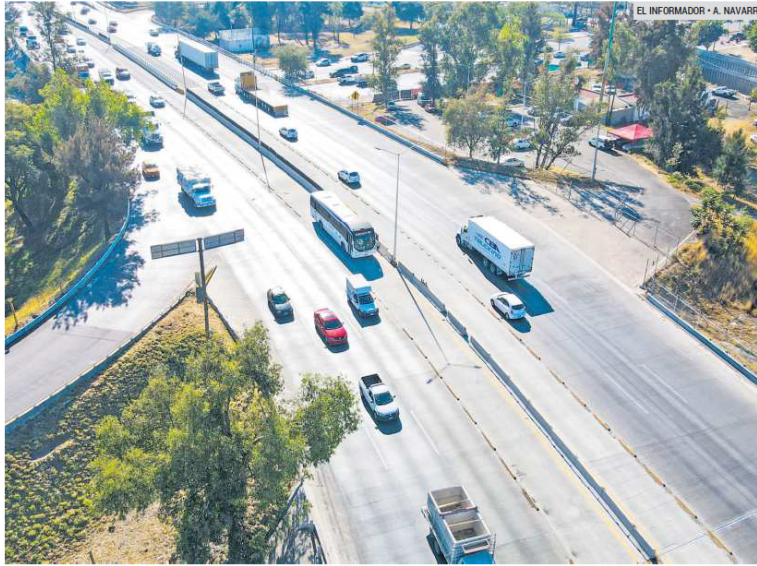
PENDIENTES. A más de un año de inaugurado, el Peribús todavía tiene pendientes en su infraestructura.
