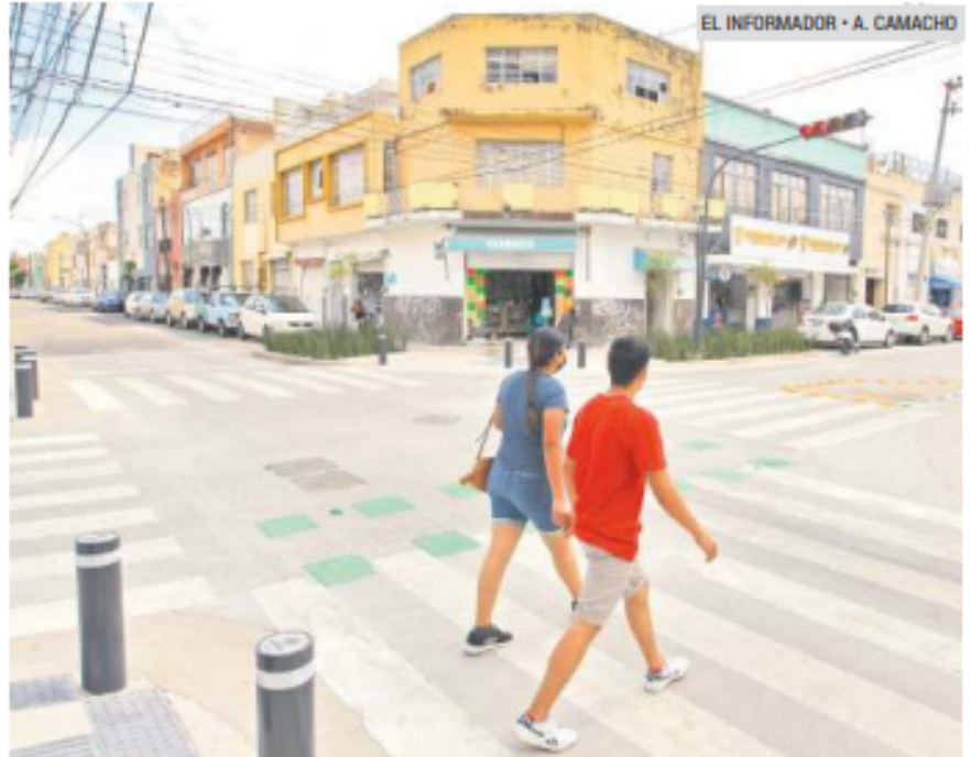
TRABAJOS. Los obras tienen 70% de avance.
