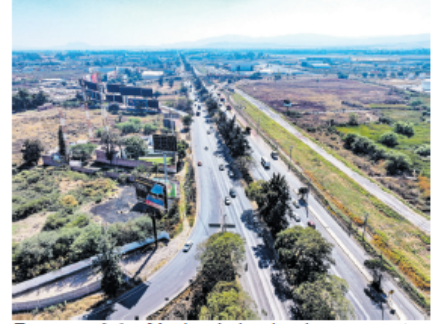
En remodelación la vía hacia el aeropuerto.
