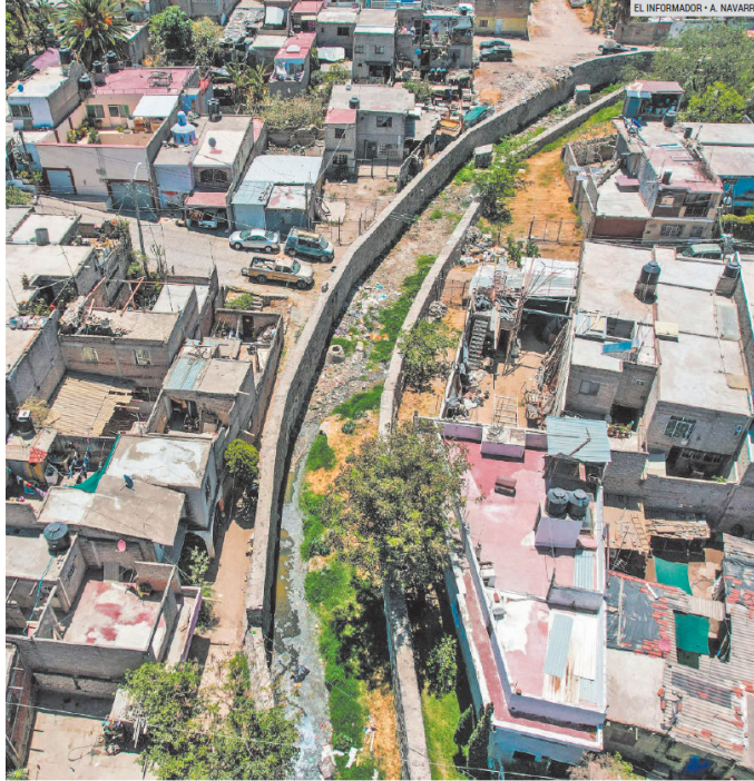
ARROYO SECO EN ZAPOPAN. El canal atraviesa una zona habitacional densamente poblada en el área metropolitana, evidenciando los riesgos de inundación en donde las casas están cercanas.
