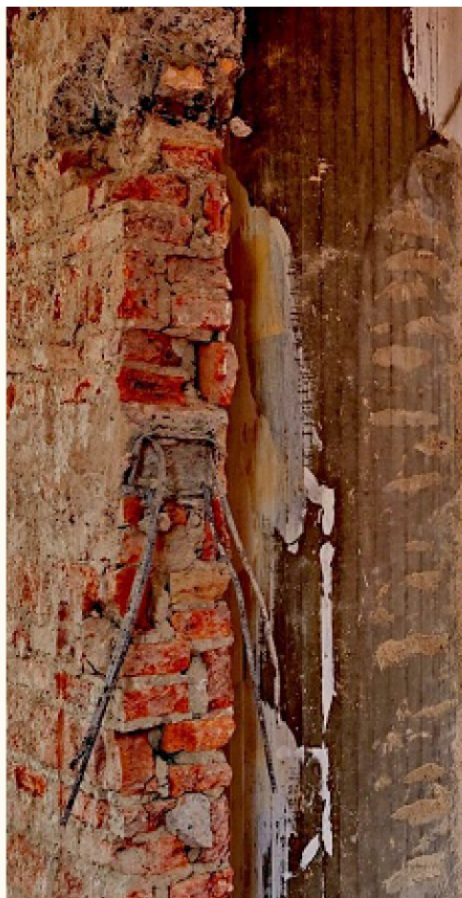
■ Interior del Centro Universitario de Guadalajara, diseñado por Salvador de Alba Martín, que está en proceso de restauración.
