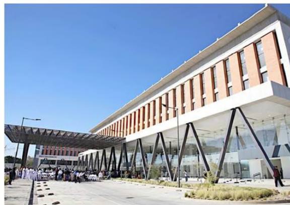
En infraestructura de salud se logró la puesta en marcha del Hospital Civil de Oriente.
