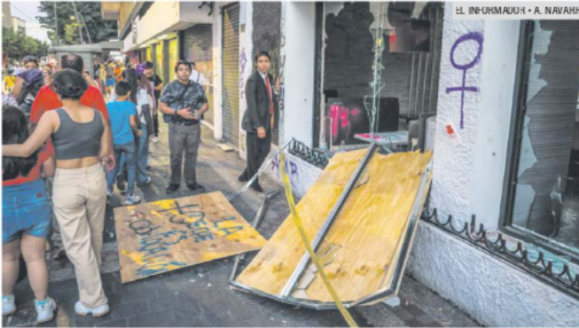
DAÑOS EN NEGOCIOS. En la Zona Centro algunos restaurantes, bancos y parabuses sufrieron intervenciones de las manifestantes.
