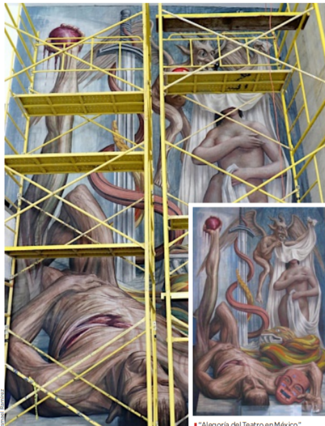
La obra requiere retirar polvo, smog y rellenar grietas por los sismos y el paso de camiones pesados.
